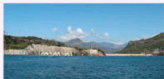
Figura 4.8 Presa hidroeléctrica en Chicoasén, Chiapas
