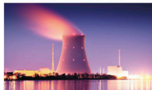
Figura 15.12 Torres de enfriamiento en una central nuclear
